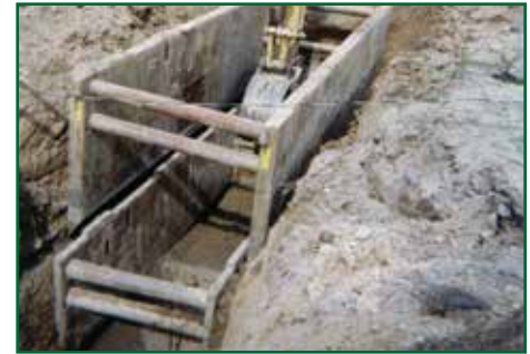
Placa de Doble Pared en Acero de 100 mm con Revestimiento Interior
