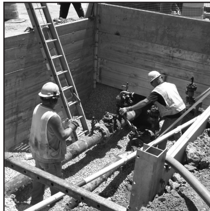
Une configuration à trois côtés avec des panneaux d'extrémité
