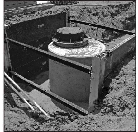
Configuration recto verso avec de longs écarteurs pour l'installation de la manole
