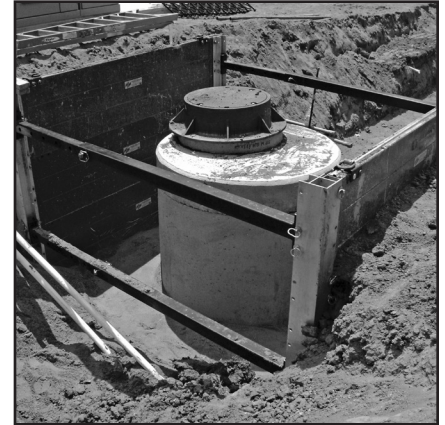
De dos lados configurados con separadores largos para instalación de manole
