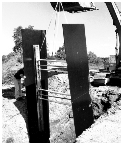
Los rieles pueden estar atornillados a planchas Fin Form, etc. (Véase página 1 para obtener información sobre planchas alternativas)
